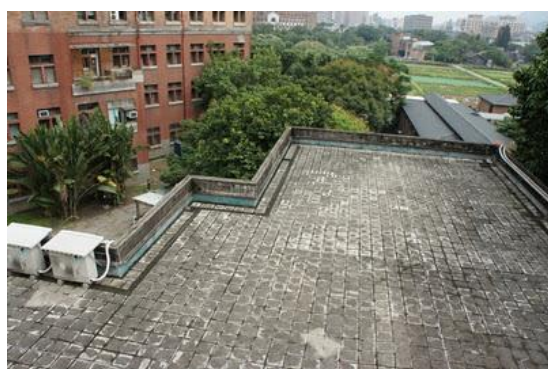
圖 59. 由風力塔下望幾經改建的二樓樓頂。
