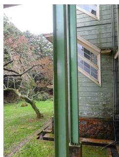
圖 13. 舊有樓梯窗戶外觀
