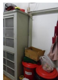
圖 8. 暗房入口門已被堵住
