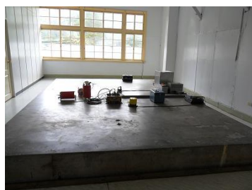
圖 6. 現存地震儀室與置放儀器平台
