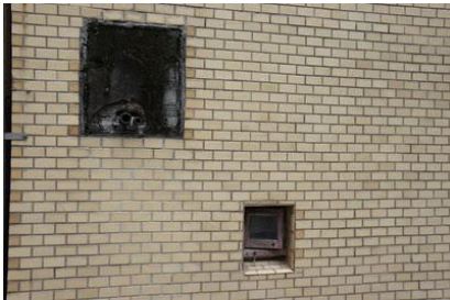
圖 52. 引光用的窗孔與一些管線的出口。
