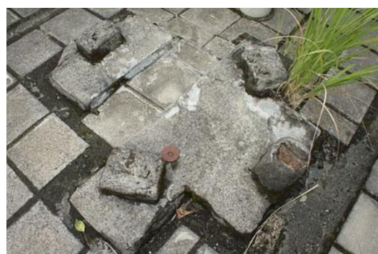
圖 62. 風力塔曾裝有儀器的基座痕跡。
