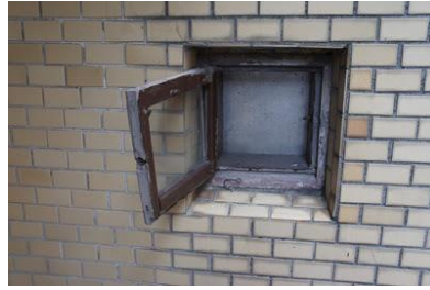
圖 49（左）、50（中）、51（右）。當年光象室作為引光用的方形窗孔。
