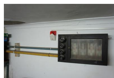
圖 3. 地下室 A115 室留有帝國大學時代電氣管線的原始塗裝樣貌。
