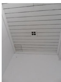
圖 9. 地震儀室天花板的透氣孔
