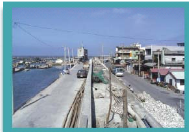
台灣西南部大量抽取地下水造成地層下陷，常受海水倒灌而造成嚴重傷害。
